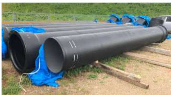
写真 基幹管路更新工事
