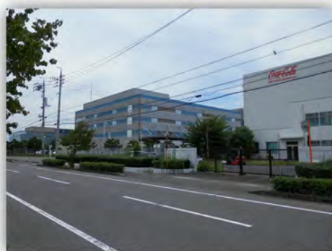
産業軸である(都)愛岐大橋線周辺に位置する和田工業団地
