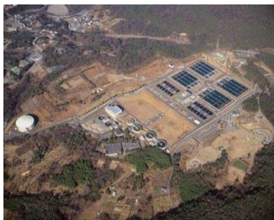
図 2.9 犬山浄水場全景
