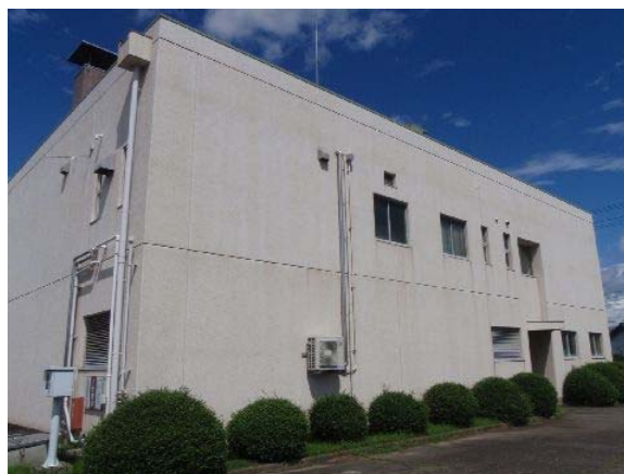
図 1.2 後飛保配水場
