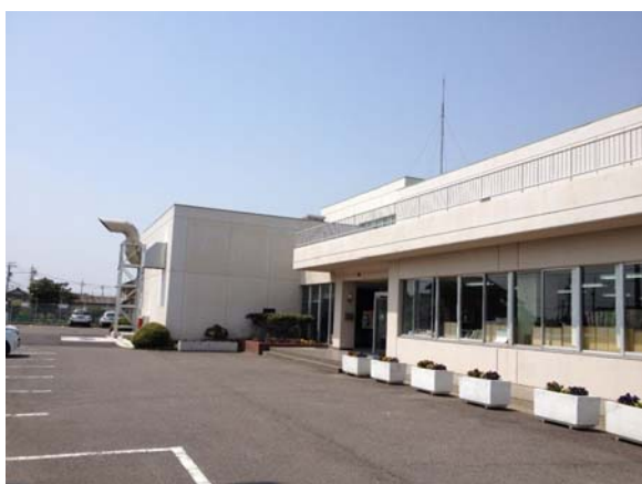
図 1.1 下般若配水場
