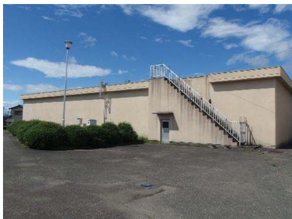
図 2.12 後飛保配水池外観
