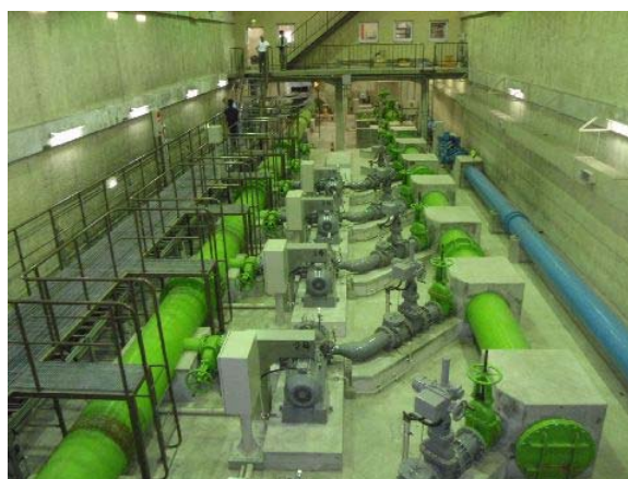
図 2.11 下般若配水場ポンプ室
