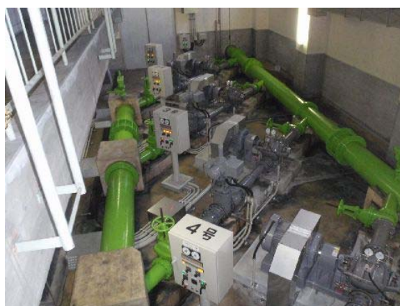
図 2.13 後飛保配水場ポンプ室
