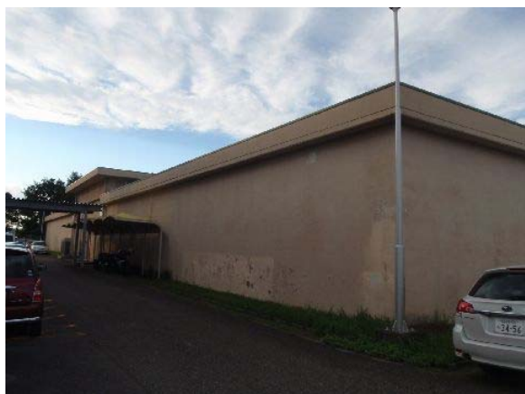
図 2.10 下般若配水池外観
