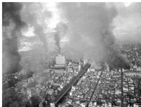
阪神・淡路大震災被災後の状況 (「阪神・淡路大震災復興誌」総理府阪神・淡路復興対策本部事務局発行より)
