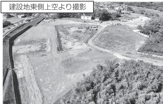
雨水調整池の整備状況
