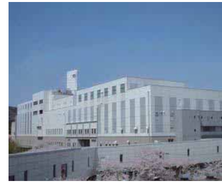
春日井市クリーンセンター 第2工場 59m
