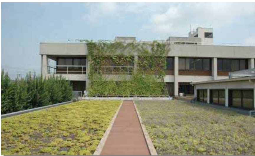
本庁舎の緑のカーテンと屋上緑化
