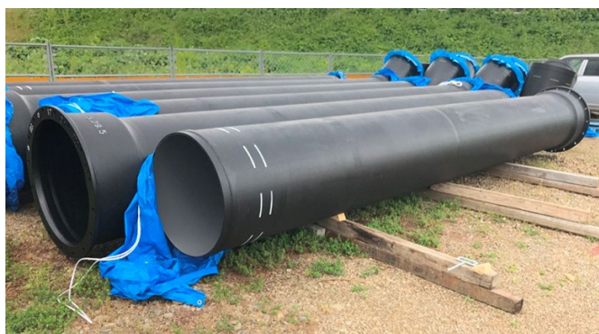
写真 基幹管路更新工事
