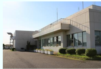
下般若配水場（外観）
