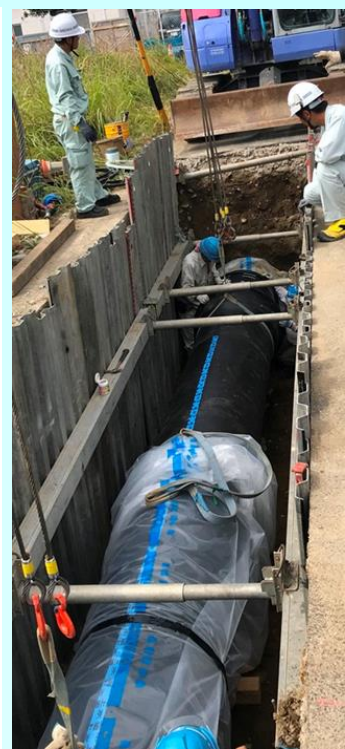
基幹管路更新工事
