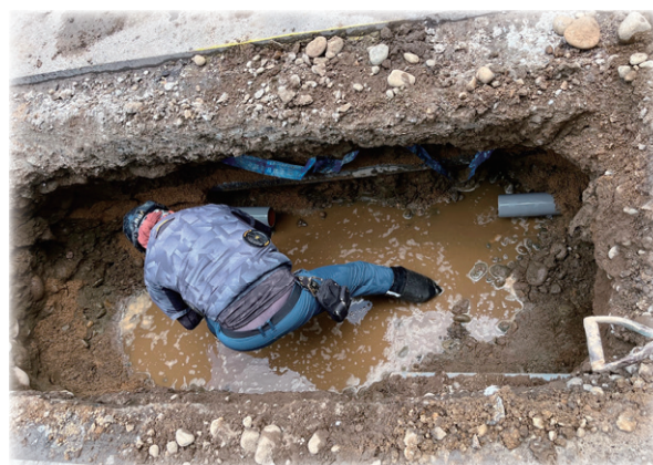
漏水発見後は、すぐに修繕を行います
