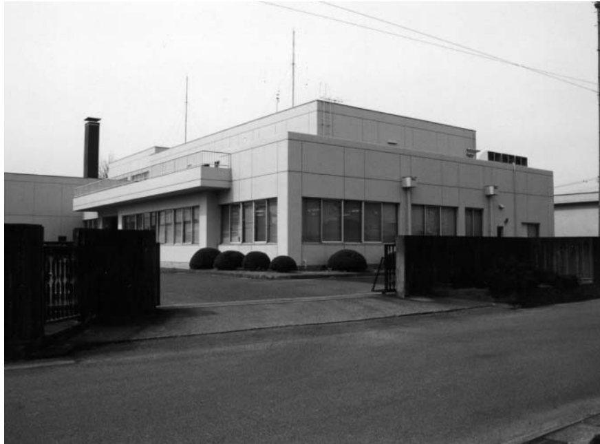
下般若配水場
