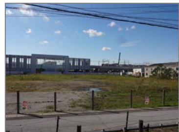
図 整備予定地の状況
