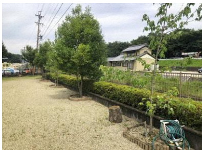
学習等供用施設小脇会館 (H5 建設 劣化なし)
