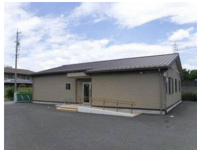
門弟山小学校学童室 (H27 建設 劣化なし)
