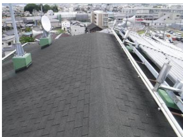
布袋ふれあい会館（劣化なし 16年経過）
