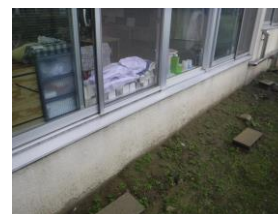
保育室外側の地盤面状況
