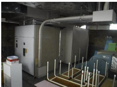
門弟山保育園 (スピーカー不良等) 改修履歴「H5 便所、H9 空調、H17 給水管、 H24 ガス管、H29 調理室空調」
