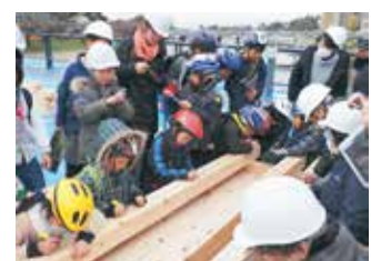
額田産木材の橋建設現場見学
