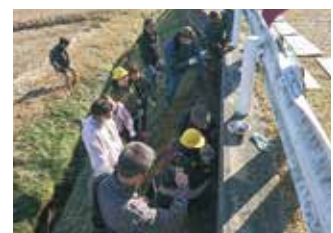
溶岩パネル張り作業
