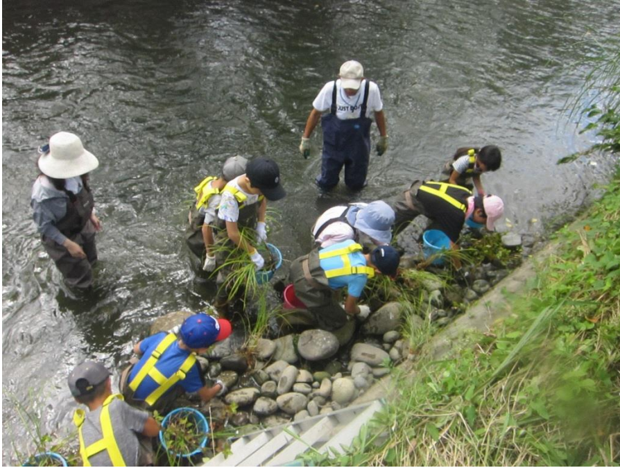
(五条川生物調査及び多自然化作業) 五条川に岸边をつくり、植栽を行います。
