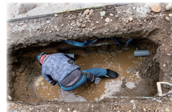
漏水発見後は、すぐに修繕を行います
