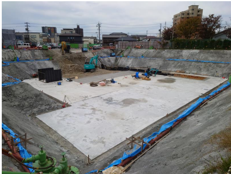
雨水貯留施設 工事状況（古知野高等学校）
