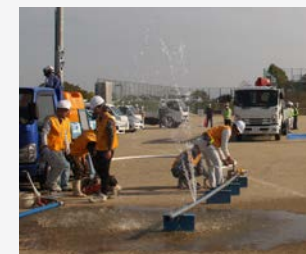
応急復旧訓練
